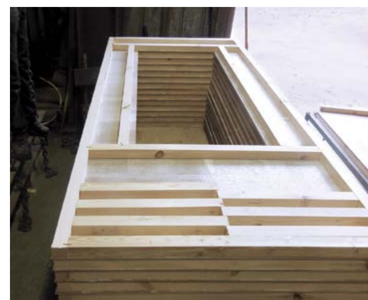
Сборка каркаса двери
