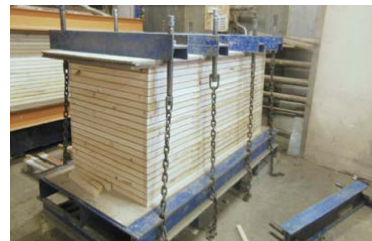
Склеивание дверных полотен
